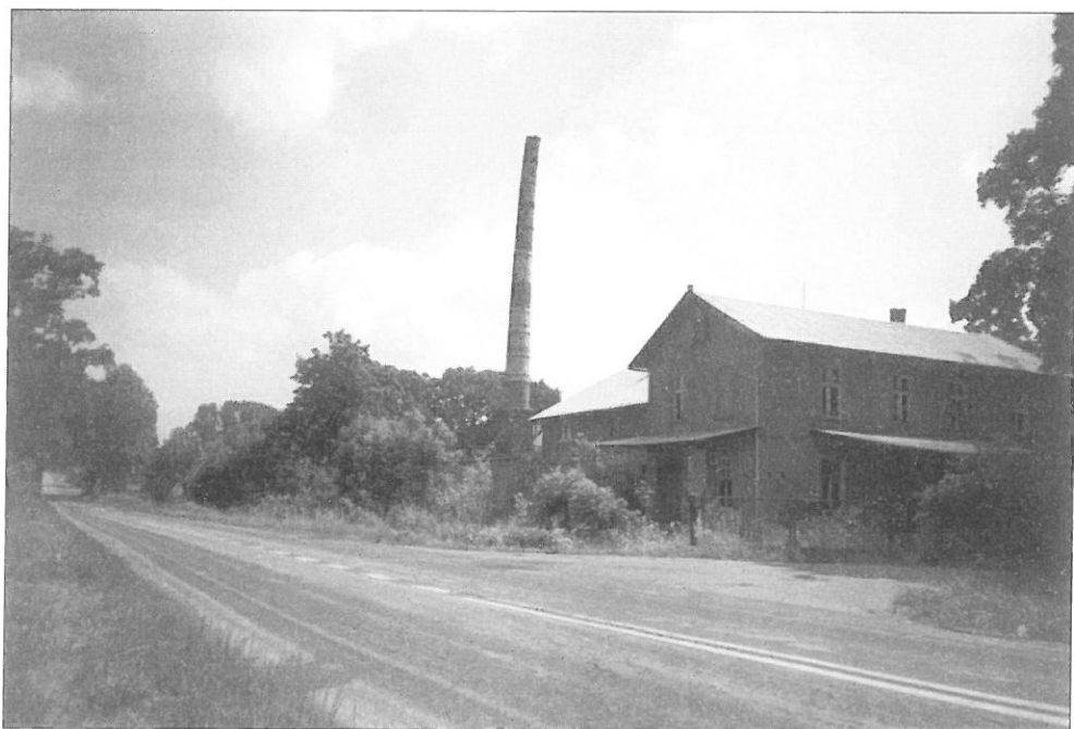
Ilustr. 3. Cerkwica, budynek mleczarni, 2002. Fot. S. Wesołowska
